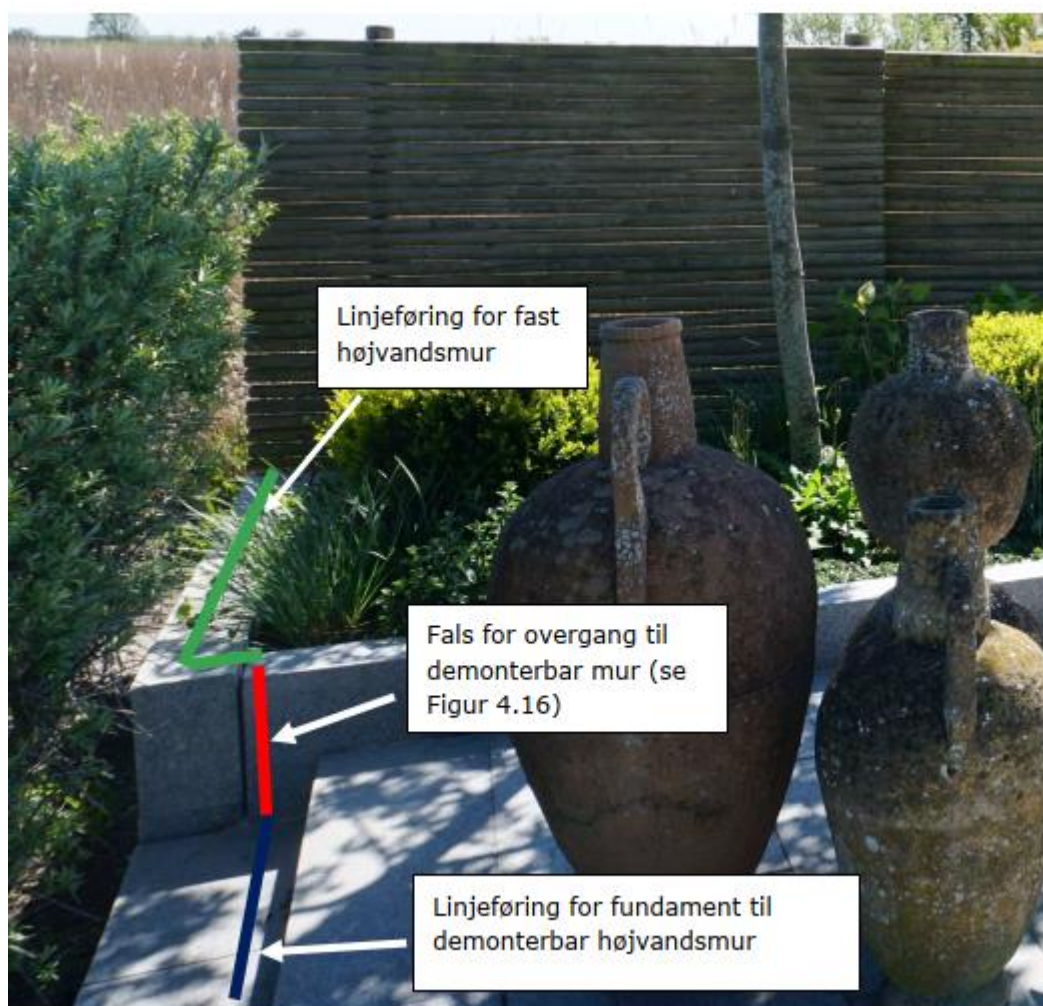
Fig 5.18. Foto fra Fuglesangsvej 20 mod syd med indikation af linjeføring ved overgangen mellem fast og demonterbar højvandsmur.
