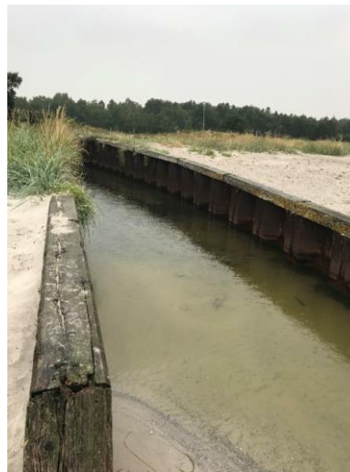
Fig 3.5 Rørunderføring af Karlstrup Mosebæk ved strandvejen
