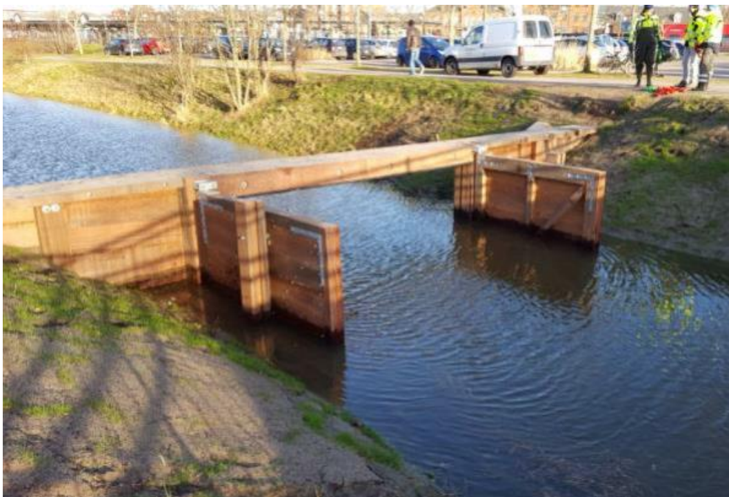
Fig. 5.10. Eksempel på sidehængte sluseporte, som foreslået af Rambøll. Typen lader sig ikke etablere uden overligger.
