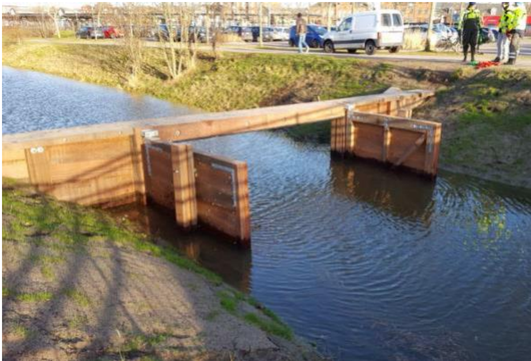
Fig 5.8. Eksempel på sluse med sidehængte porte.
