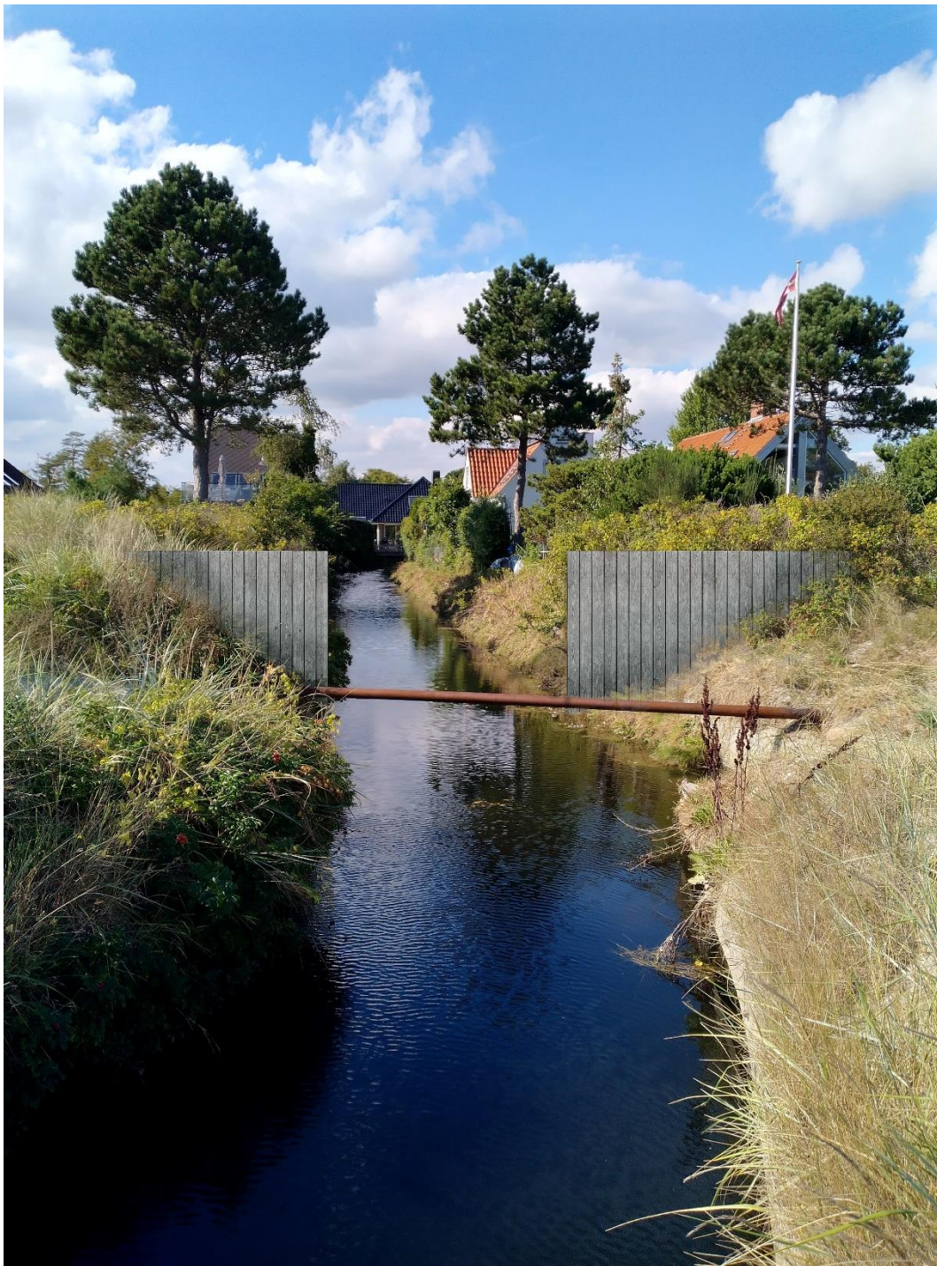
Fig 5.9. Visualisering af hæveluse. En hæveluse kan anlægges uden overligger, og dermed blive mindre fremtrædende i terræn.
